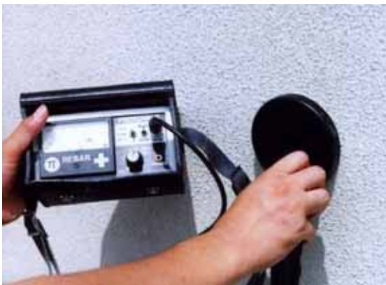
写真-4 鉄筋探知機による調査
