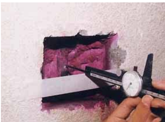
写真-10 鉄筋のかぶり厚さの測定
