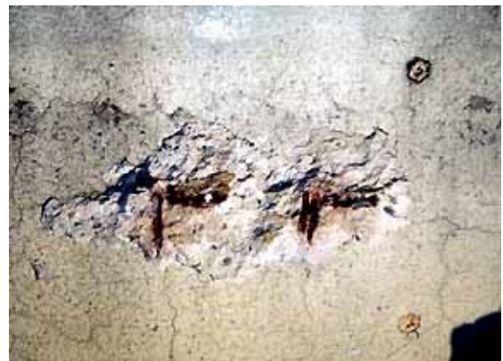
写真-7 腐食した鉄筋周辺のコンクリートのはつり作業
