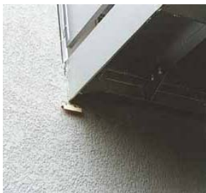
躯体と鉄骨階段の取合い部の改善例
