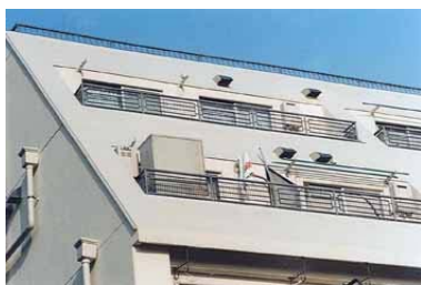
斜庇先端の水切り設置例
