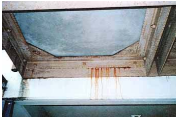
躯体と鉄骨階段の取合い部
