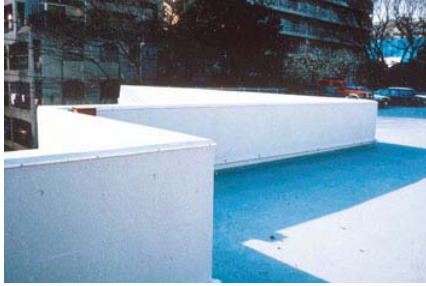
腰壁天端の汚染防止処理
