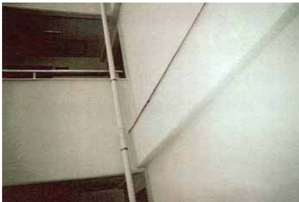
外壁梁型への水切り設置例
