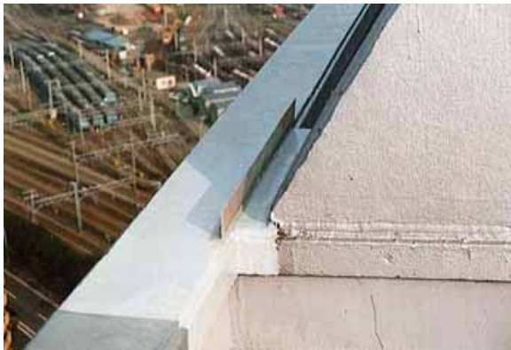
塔屋斜梁型下端への水切り設置例
