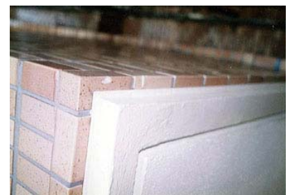
内壁天端の水切り設置例
