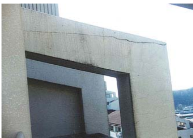
受熱・雨水対策が必要な斜梁型
