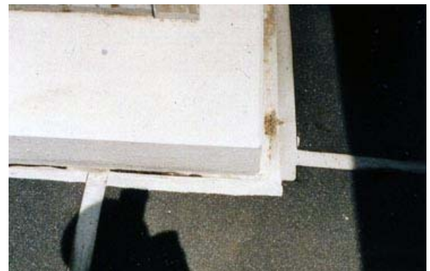
基壇まわりに施したウレタン系シーリング材が破断している。
