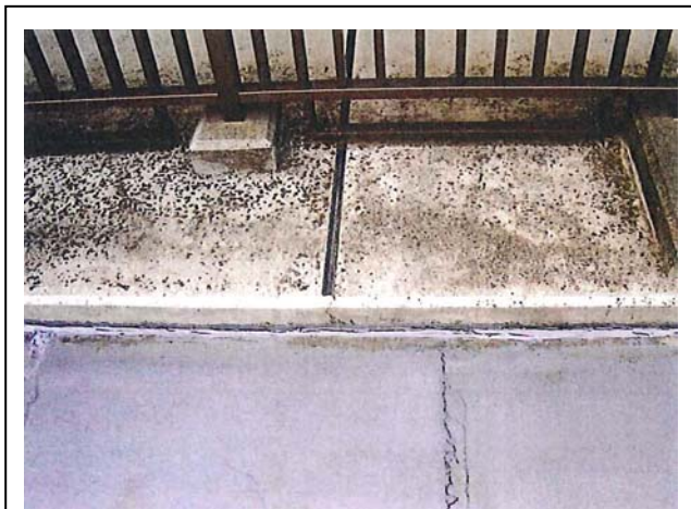
露出アスファルト防水層の上に、一部コンクリ ートの土間が載っている。
