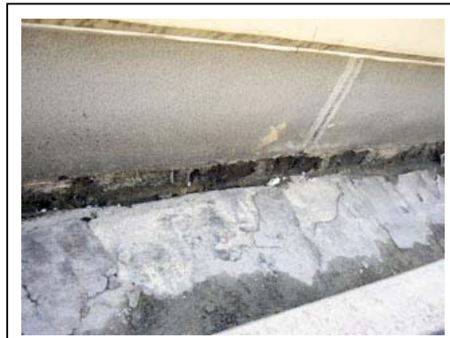
押さえモルタルや断熱材を撤去する。
