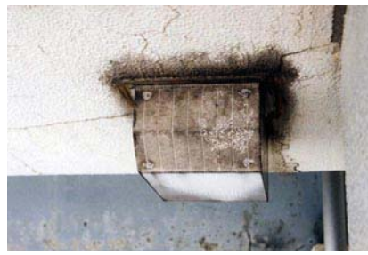
吹き上げ風がフード上面メッシュから抜け、逆流防止となるタイプの換気口
