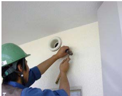
排気口の清掃のため換気カバーを取り外している。
