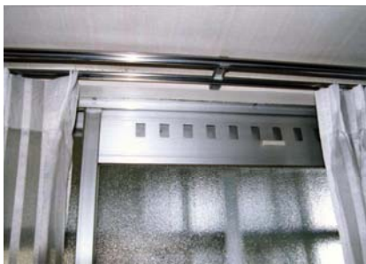
サッシに換気口がついた上権がついており、窓を閉めた状態でも換気ができる。
