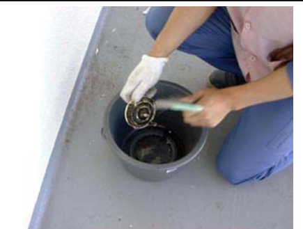
取り外した浴室換気扇の吸い込み口カバーをブラシで清掃する。
