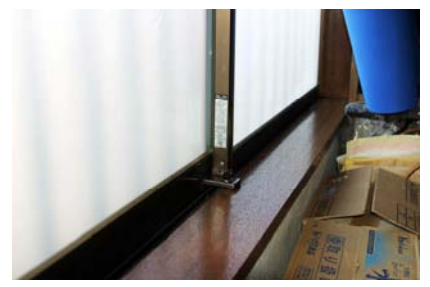
防犯錠を取り付けた上、ドアの合わせ部にすき間を設け、給気を確保した。防犯上は注意が必要。
